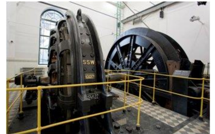
Maszyna wyciągowa z kołem Koepe na szybie „Julia-Wschód”
